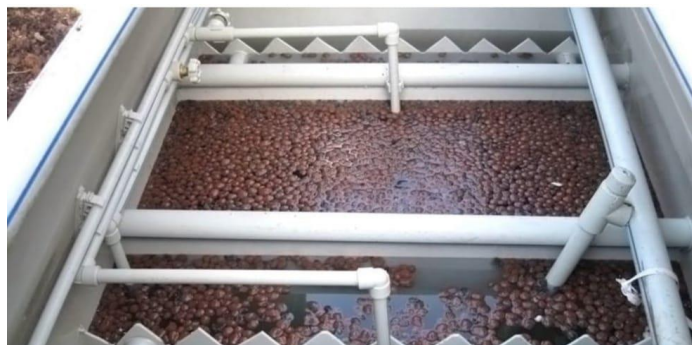
Рисунок 1. Фильтрующий керамзитовый компонент в фильтре
