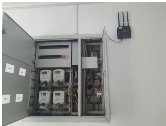
Сурет 3 –LoRaWAN жүйесімен жабдықталған көп пәтерлі тұрғын үйде орнатылған көп тарифті бір фазалы санауыш
