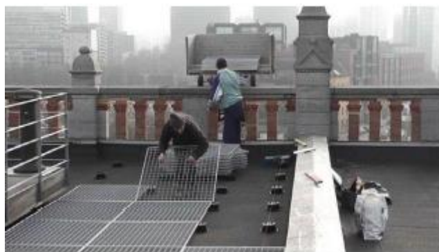
Сурет 5 – Тіректерге торлы төсемнің құрылысы
