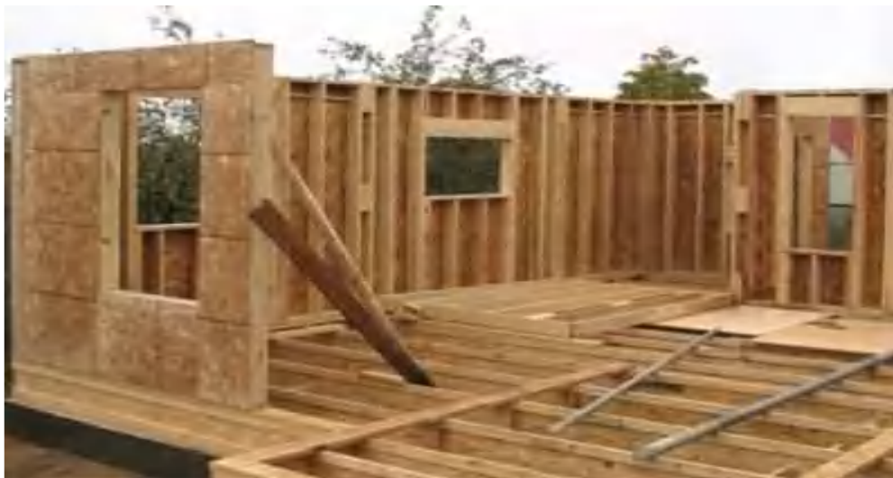
1 сурет – Қаңқалы-қалқан ағаш үйі монтаждау процесінде
