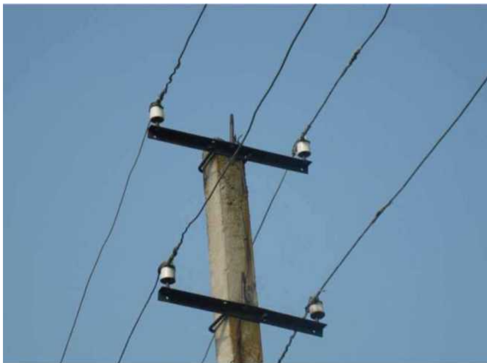
1 сурет – Оқшауланбаған сымдардан жасалған электр жеткізуші желі
