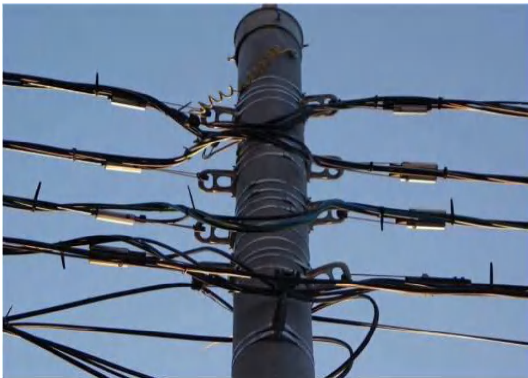
2 сурет – Оқшауланған әуе желілері
