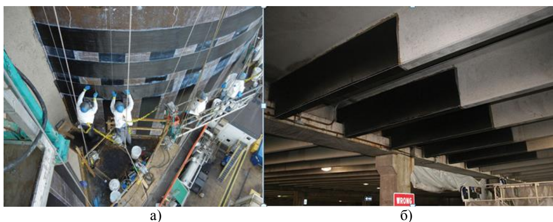
а) өнерәсіптік силосты күшейту; б) паркинг арқалықтарын көмертегі негізіндегі композициялық материалмен күшейту
