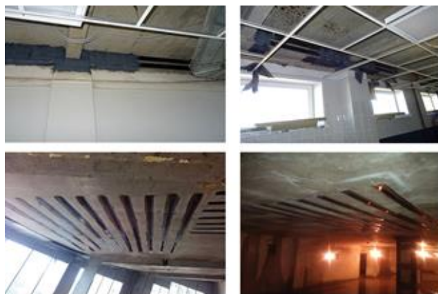
4-сурет – Богучан алюминий зауытының тұтас құймалы темірбетон аркалықты төбе жабындарын нығайту (АҚ «РУСАЛ»)
