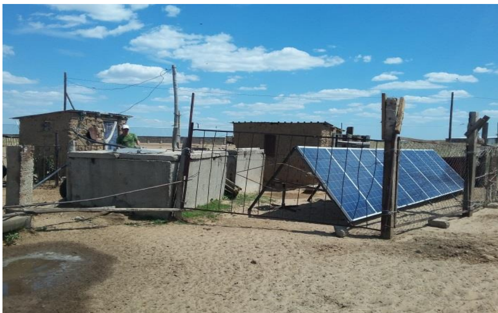
2 сурет - Шаруа қожалықтарындағы ұңғымалар мен құдықтарды электр қуатымен қамтамасыз ететін күн батареялары
